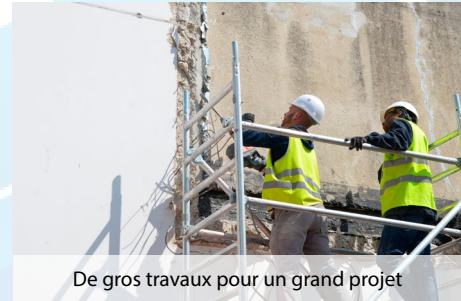
De gros travaux pour un grand projet
