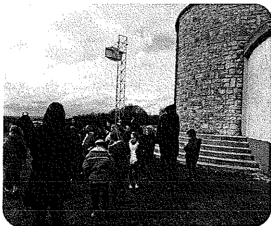
Visite réservoir de Fère en Tardenois
