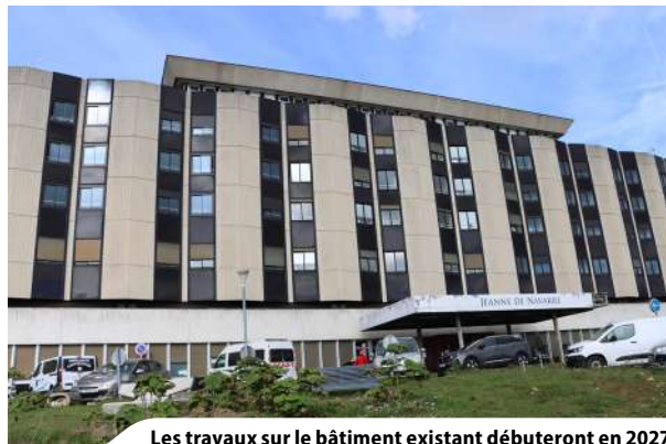
Les travaux sur le bâtiment existant débiteront en 2027
