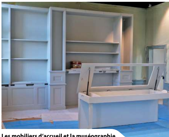
Les mobiliers d'accueil et la muséographie sont progressivement installés
