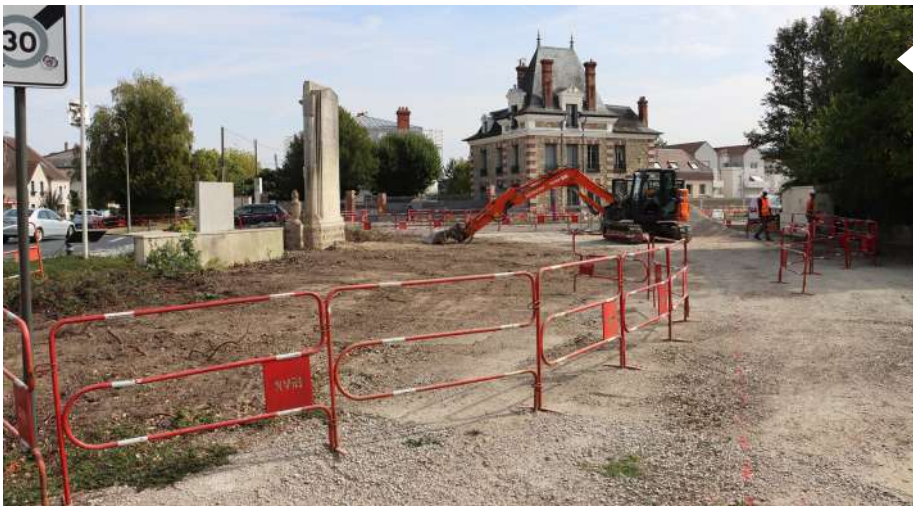
Le chantier de l'avenue de Montmirail a débuté, avec pour objectif d'améliorer et d'apaiser cette entrée de ville
