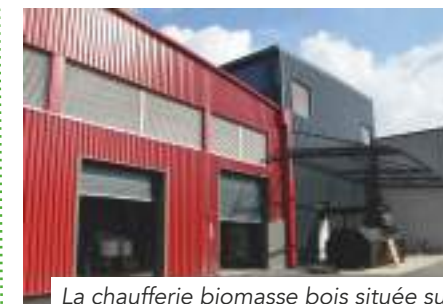
La chaufferie biomasse bois située sur la zone d'activités de la Moiserie
