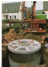
Installation d'une citerne enterrée
