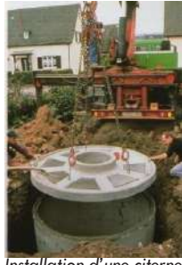
Installation d'une citerne enterrée
